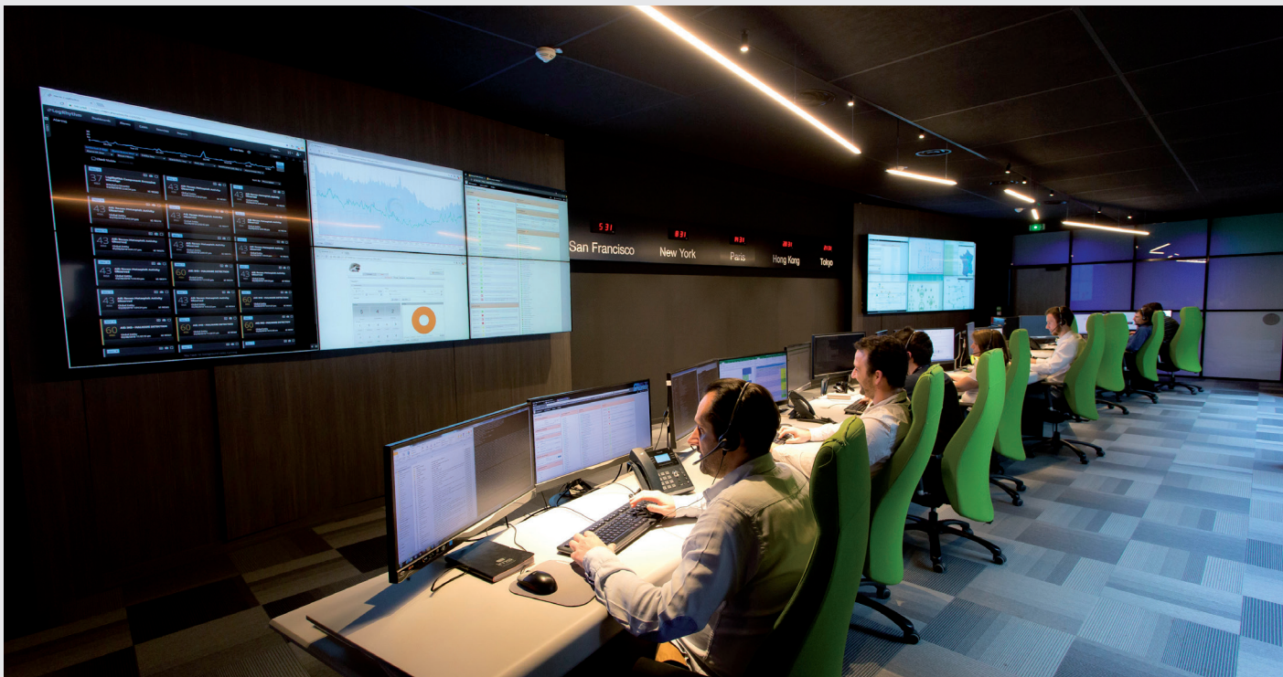
Centre opérationnel du réseau et de la sécurité NSOC d'IMS Networks à Castres.
